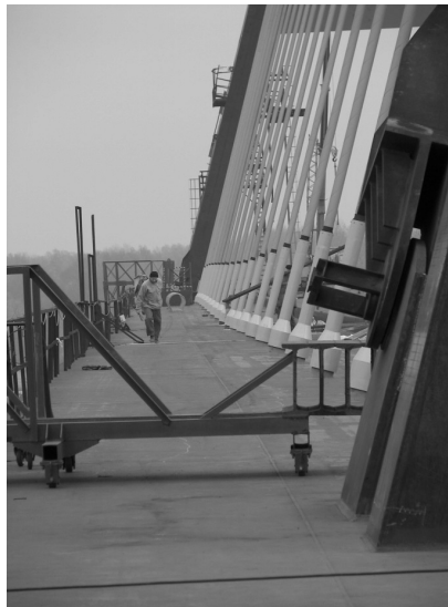
6. ábra. A híd alakja a beúsztatás közben (a feszítópásmákon a fekete gyűrűket érdemes figyelni)
